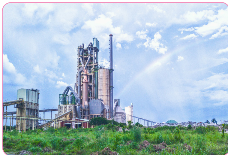
Hình 2.10. Nhà máy xi măng Bình Phước (Nguồn: Sở Giáo dục và Đào tạo Bình Phước cung cấp)
