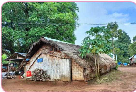
Hình 6.2. Nhà của người S'tiêng nhánh Bù Lơ (Nguồn: Sở Giáo dục và Đào tạo Bình Phước cung cấp)
